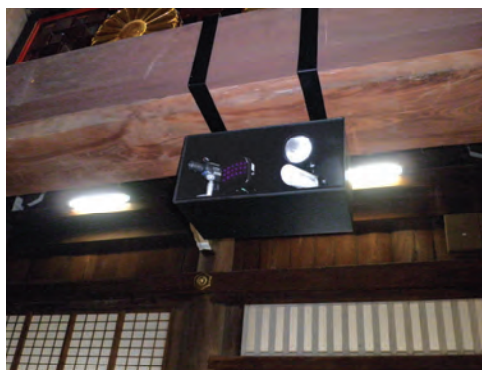
専修寺御影堂内6カ所にBoschデイナイトカメラ、AEGIS赤外線照明器を設置
