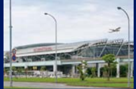
福岡国際空港(中規模放水銃) Fukuoka International Airport
