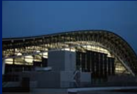
関西国際空港ターミナルビル(大規模放水銃) Kansai International Airport terminal
