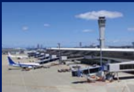
中部国際空港セントレア (中・小規模放水銃) Chubu Centrair International Airport
