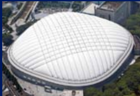
東京ドーム (大規模放水銃) Tokyo Dome
