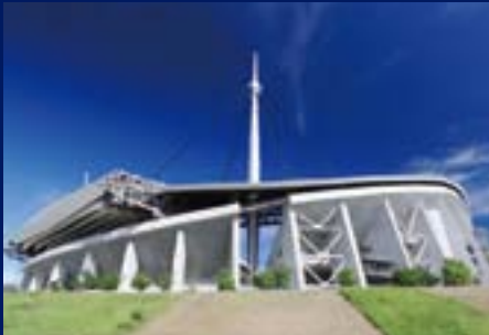
豊田スタジアム(大規模放水銃) Toyota Stadium
