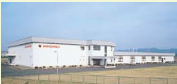
宮城第1工場 Miyagi Plant #1
