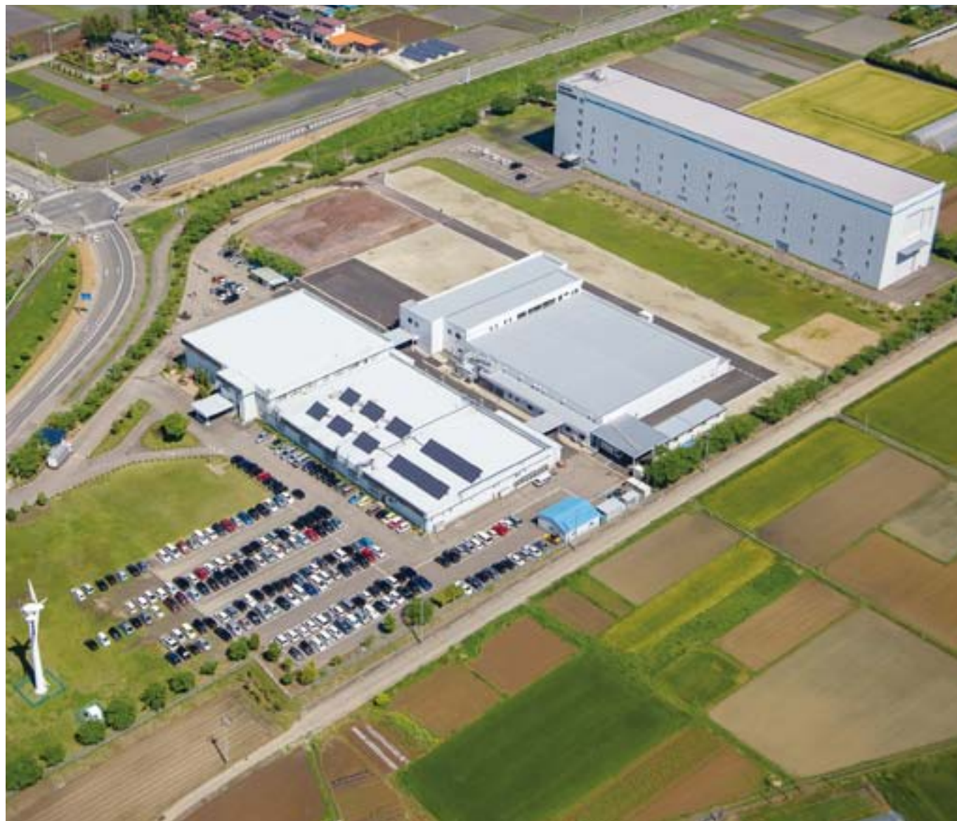
宮城事業所 全景／角田市
